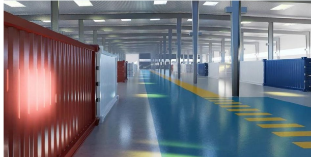
La ligne de production industrielle d'épurateurs biogaz et de liquéfacteurs BioCO 2 | Crédit Photo : AVENTECH
